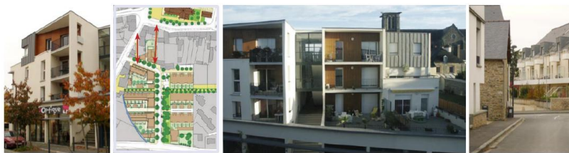
ZAC des Vignes à Servon-sur-Vilaine, 78 log/ha
